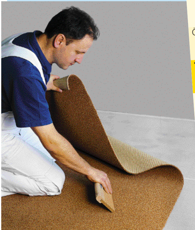
Schutzpapier abziehen und Bodenbelag einlegen
