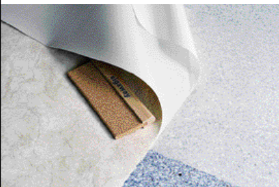
PVC/CV direkt auf alten PVC-Boden.
